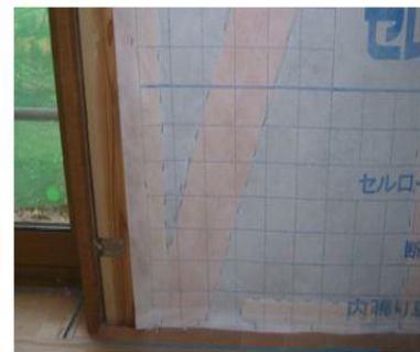
隙間のない施工
