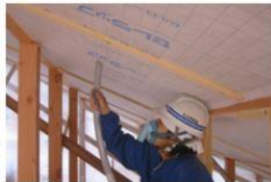
屋根吹き込み施工
