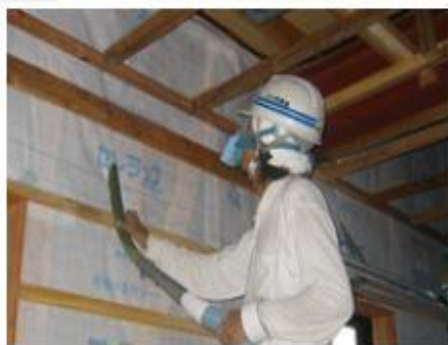
壁吹き込み施工
